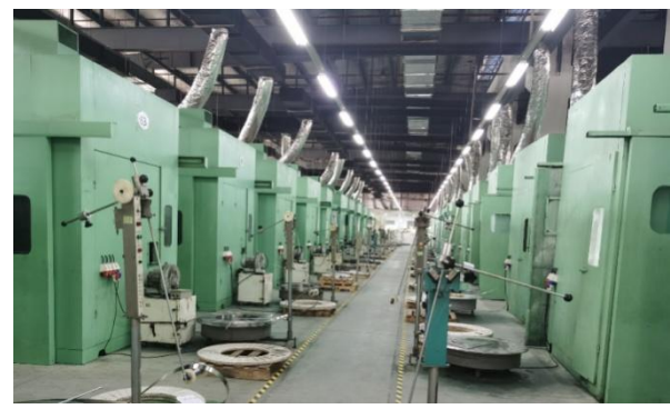
冲压车间实景
