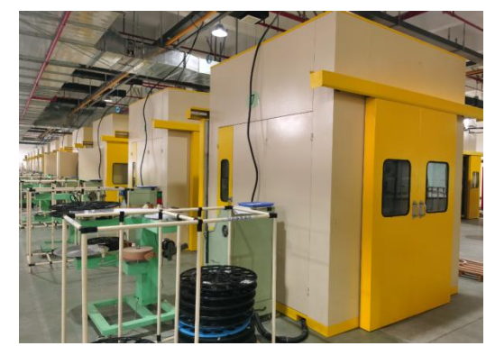
冲压车间实景
